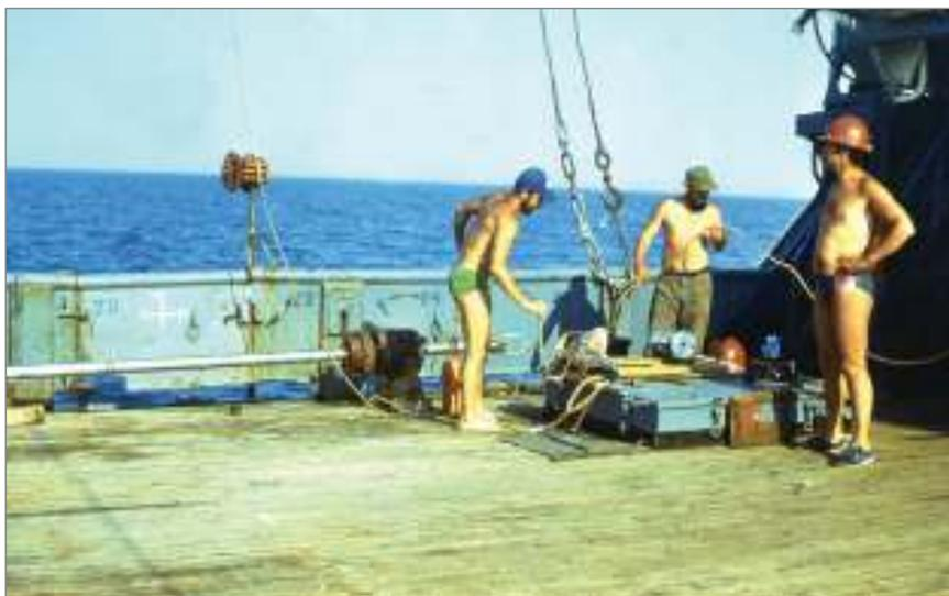
Рис. 15. Подготовка батометра к спуску
